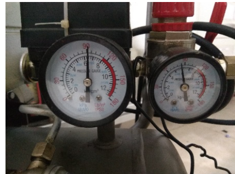
Gambar 9 Pengujian Tekanan Udara
